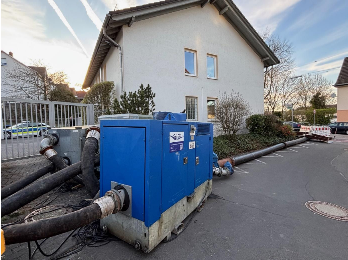
Bildunterzeile: Mobile Pumpenaggregate mit Saug- und Druckleitung, um das Wasser des Köttingsbachs umzupumpen.
